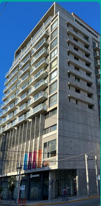
Edificio Casa Club
