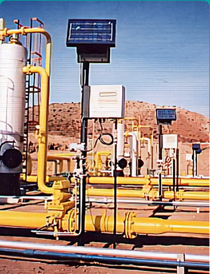
Instrumentación y sistema scada batería YPF
