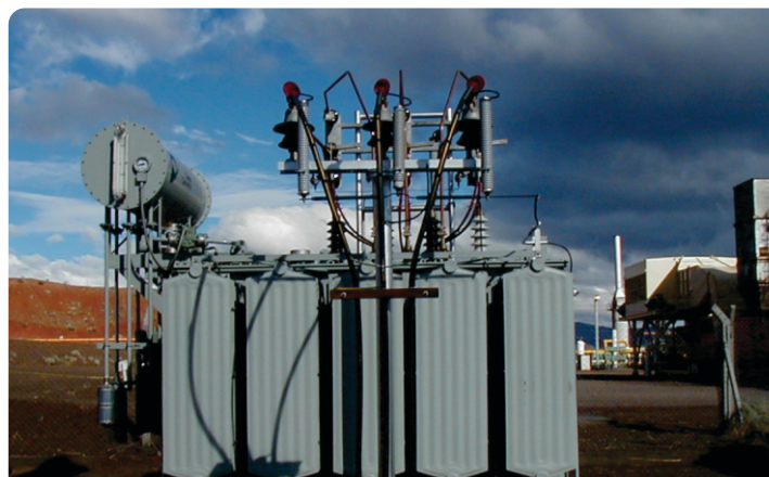
Montaje de transformador de reserva en Filo Morado
